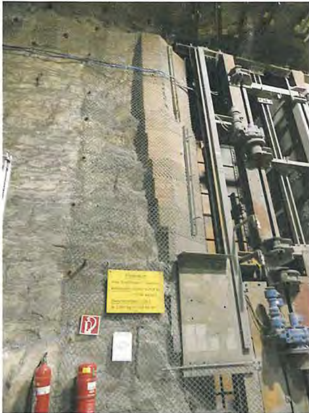
(a) Blick auf den westlichen Teil des Schachtes 2 am Füllort auf der 490-m-Sohle, Stand: 27.02.2020
