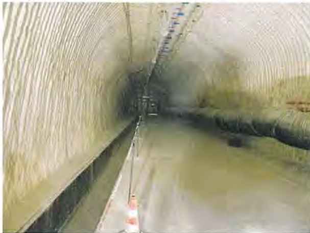
(c) Blick nach Norden in die Schachtumfahrung des Schachtes 2, Stand: 27.02.2020
