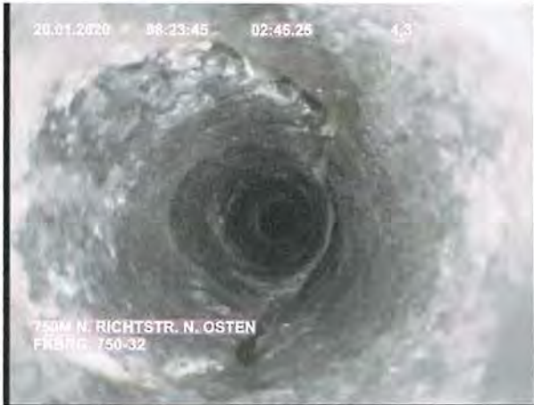
Bild 97: FKBrG. 750-32 – Position bei 4,2 m Aufgelockerter Bereich bis 4,5 m
