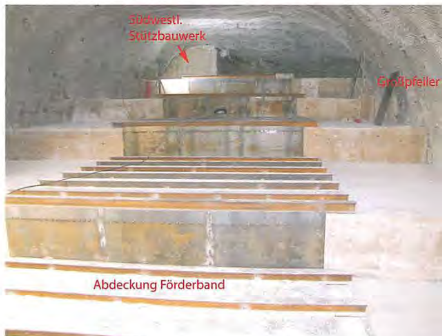
Abbildung 4.28: Abdeckung des zwischen Großpfeiler und Südstoß der 20BA ansteigend verlaufenden Förderbands mit auf den treppenartigen Stützmauerelementen montierten Stahlplanken - in Vorbereitung einer firstbündigen Verfüllung mit Sorelbeton, Blick nach Nordwesten (20.03.2020)
