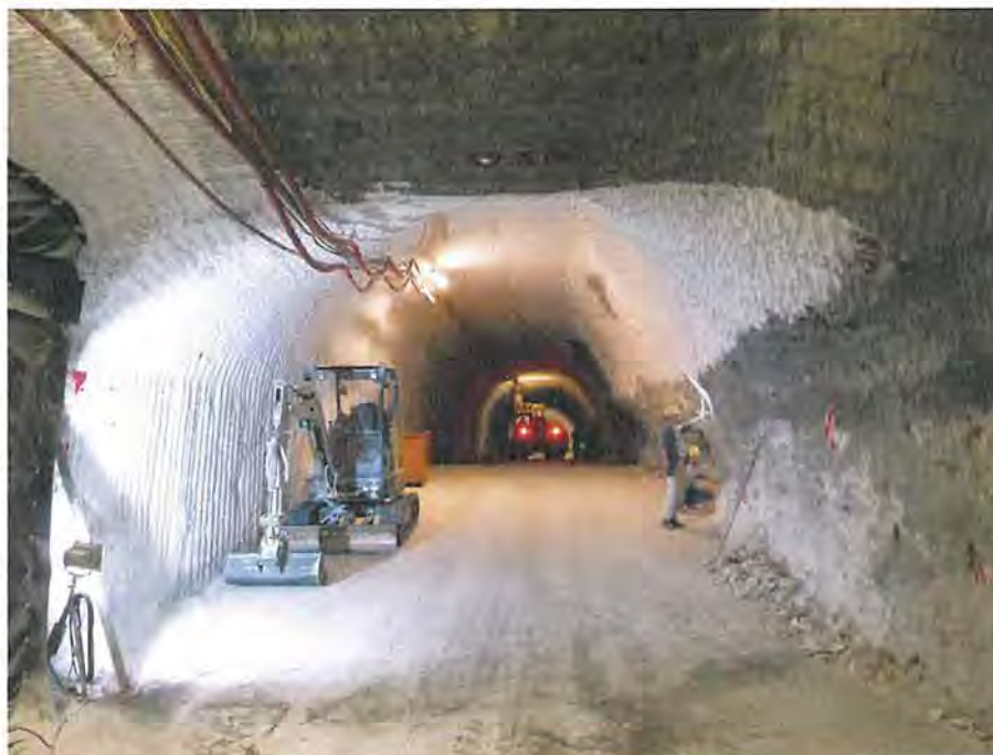
Abbildung 4.64: Nördliche Richtstrecke n. Osten östlich des Querschlags mit Grubenwehrraum am Beginn der Sohlenaufhöhung mit Sorelbeton. Nordstoß und Firste sind nachgeschnitten, der Südstoß wird zum Nachschnitt vorbereitet. Blick nach Südosten (10.03.2020)
