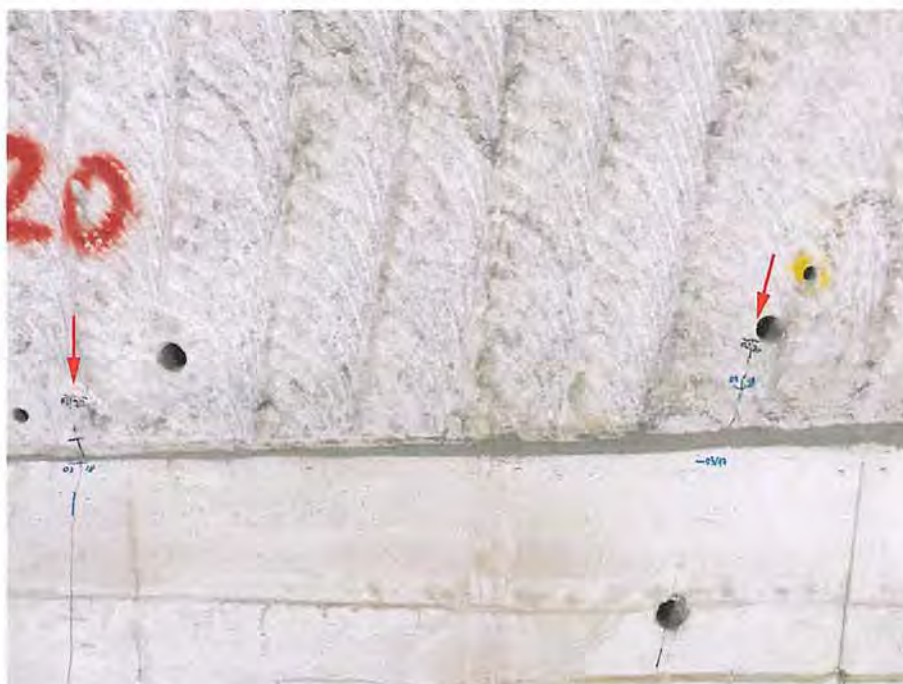
Abbildung 4.51: Die Risse im Salz und den Sorelbetonelementen des verfüllten Luttenkanals am südöstlichen Füllortstoß haben sich nur im Zentimeterbereich verlängert, Blick nach Südosten (10.03.2020)
