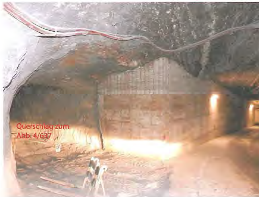
Abbildung 4.19: Südstoß der Wendelstrecke mit bis zum westlichen Pfeiler des teilweise freigeladenen Querschlags zum Abbau 4/637 erstellter Sorelbeton-Stützmauer, Blick nach Südwesten (23.04.2020)
