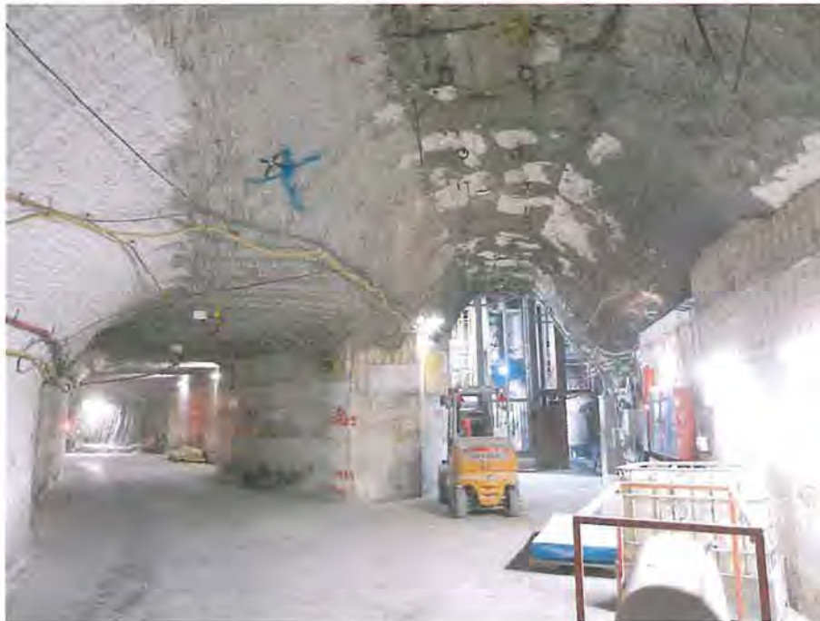
Abbildung 4.49: Füllort mit durch Stützmauern und Einbau von Mörtelinjektionsankern stabilisiertem südöstlichen Pfeiler sowie vereinzelt geraubten flachen Lösern im Firstbereich, Blick nach Westen (21.02.2020)
