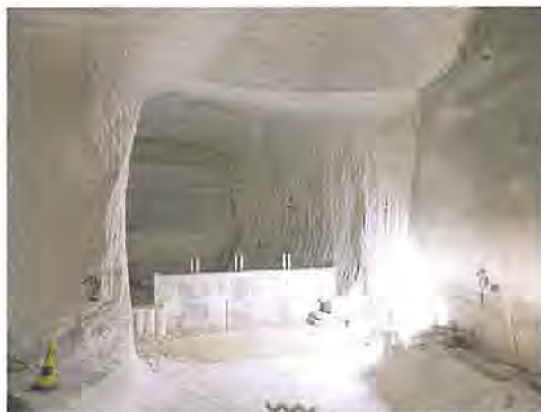
(b) Beginn der Erstellung der westlichen Schalungsmauer für die SB-532-1, Stand: 04.11.2019
