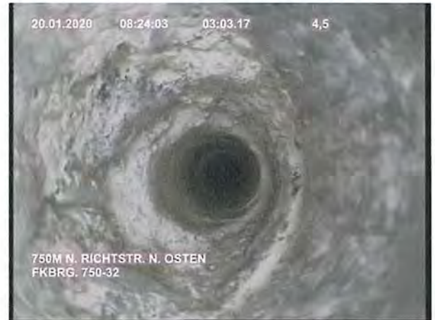
Bild 98: FKBrG. 750-32 – Position bei 4,5 m Übergang Steinsalz–Sorelbeton
