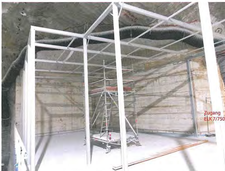
Abbildung 4.68: Sanierter Standort zur geplanten Erkundung der ELK 12/750 mit firstbündigen Stützmauern am Ost- und Südstoß, Blick nach Südosten (21.02.2020)
