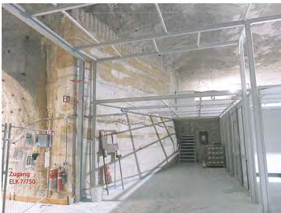
Abbildung 4.69: Durchgehend mit firstbündigen Stützmauern stabilisierter Südstoß zwischen dem Zugang zur ELK 7/750 und dem westlich gelagertem Salzhauwerk. Blick nach Süden (21.02.2020)
