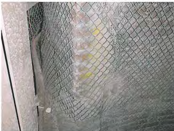
(c) Blick vom Schachtkorb auf den westlichen Stoß (Ziegelmauerwerk mit Stahlanker und Maschen-drahtverzug) im Schacht 2 auf der 490-m-Sohle, Stand: 27.02.2020
