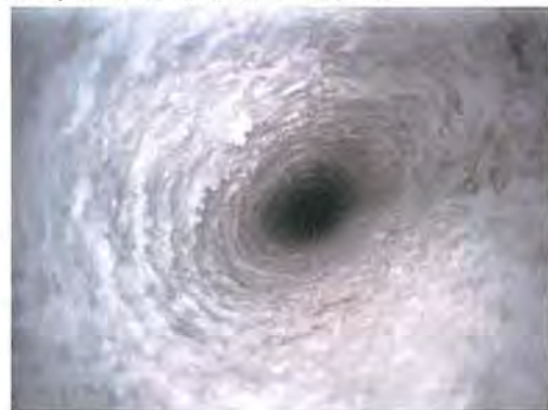
Bild 4: Bohrung 553012; elliptische Bohrlochkontur bei ca. 40 m Bohrlochteufe, Aufnahme vom 09.12.2019
