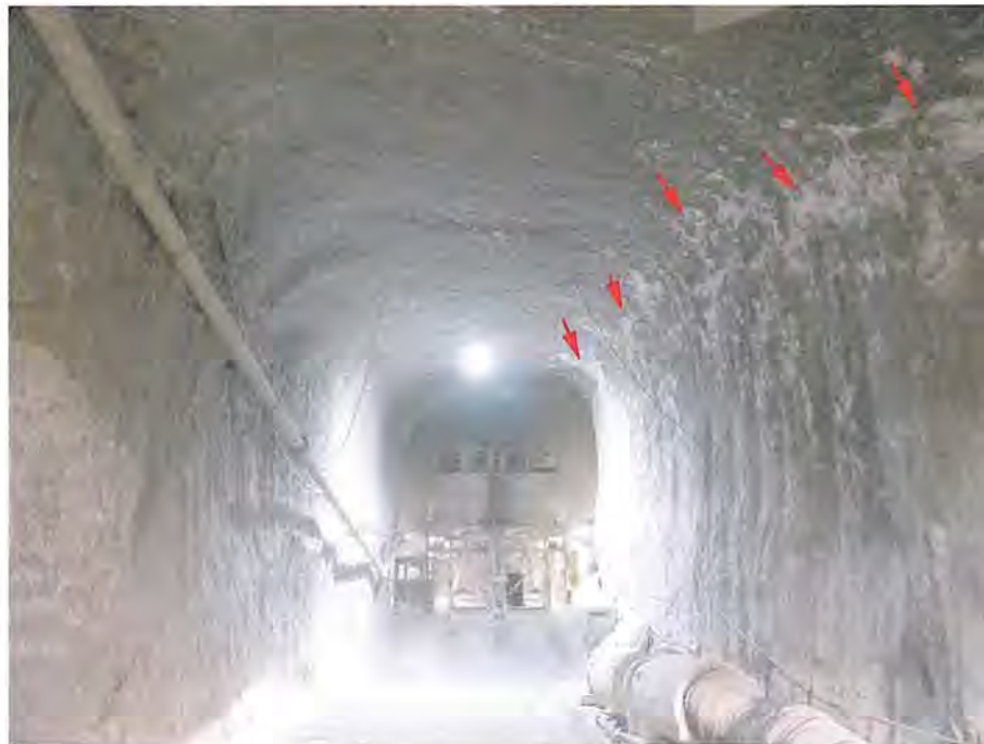
Abbildung 4.29: Baustoffanlage 50BA mit großer Firsthöhe und lokal geankerten Auflockerungen im Übergang Stoß/ Firste, Blick nach Nordosten (23.04.2020)
