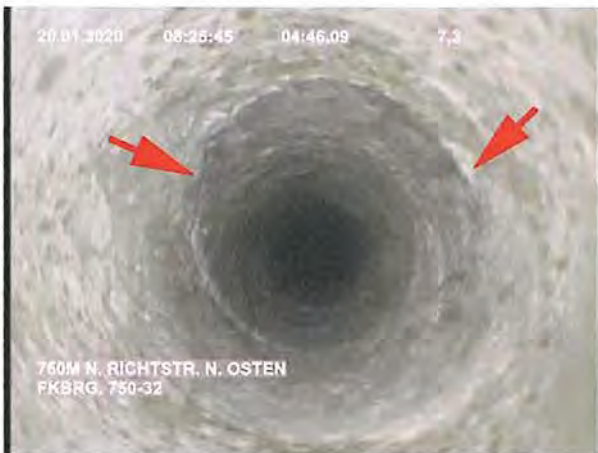
Bild 99: FKBrG. 750-32 – Position bei 7,2 m weitgehend formschlüssiger Übergang Sorelbeton–Steinsalz
