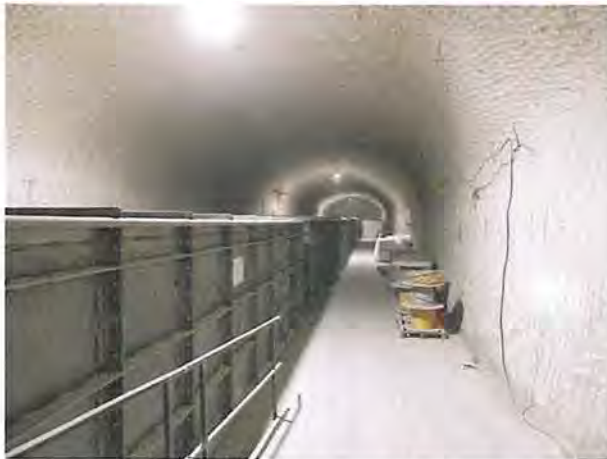
(a) Blick nach Südwesten in den Bereich der Lauge-speicherbecken, Stand: 27.02.2020
