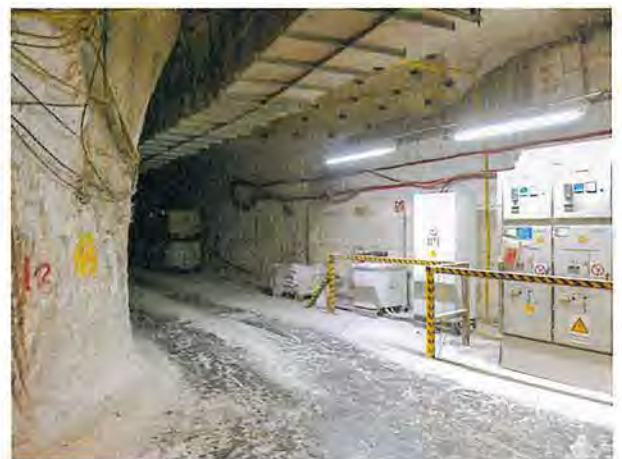
(b) Blick nach Westen in die Abbaubegleitstrecke vor Abbau 3/553 auf der 553-m-Sohle, Stand: 23.04.2020
