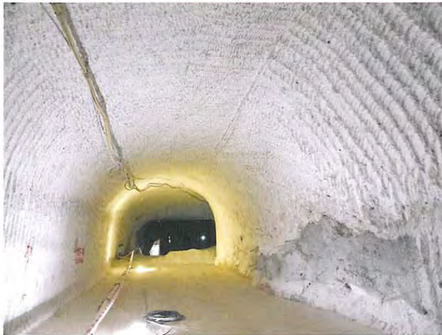
Abbildung 4.65: Nachgeschnittene Nördliche Richtstrecke n. Osten mit bis zum Abzweig des Zugangs zu Abbau 5/750 (Na2) erfolgte Sohlenaufhöhung mit Sorelbeton. Der Südstoß wird noch nachgeschnitten und mit einer Stützmauer stabilisiert. Blick nach Südosten (10.03.2020)
