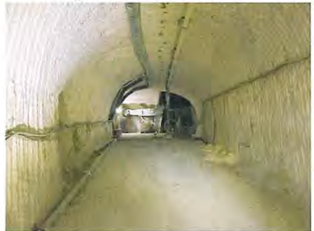
(d) Blick nach Süden in den Querschlag zum Mess-werterfassungsraum, Stand: 27.02.2020
