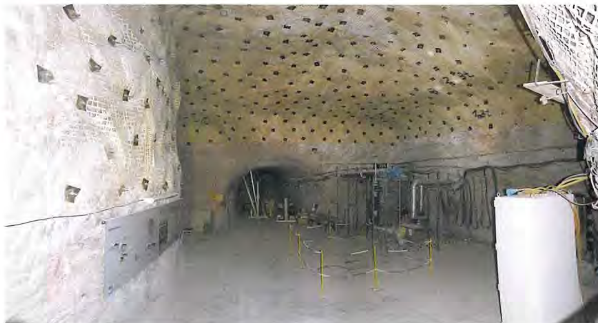
Abbildung 4.10: Blick vom Zugang zum Abbau 8/490 in die Beschickungskammer auf der 490-m-Sohle, Stand: 27.02.2020
