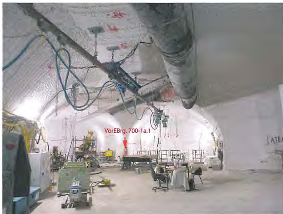
Abbildung 4.33: Zentraler Bohrort mit nordöstlich bzw. östlich abgehenden Teilbohrörter und Lage der Vorerkundungsbohrung VorEBrg.700-1a.1 in dem Pfeiler dazwischen, Blick nach Osten (05.03.2020)
