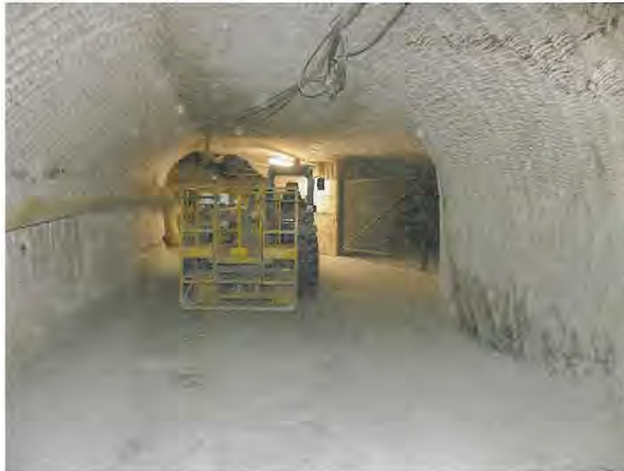
Abbildung 4.15: Blick nach Süden in den ehemaligen Zugang zur Wetterstrecke zum Blindschacht 1 auf der 574-m-Sohle, Stand: 23.04.2020
