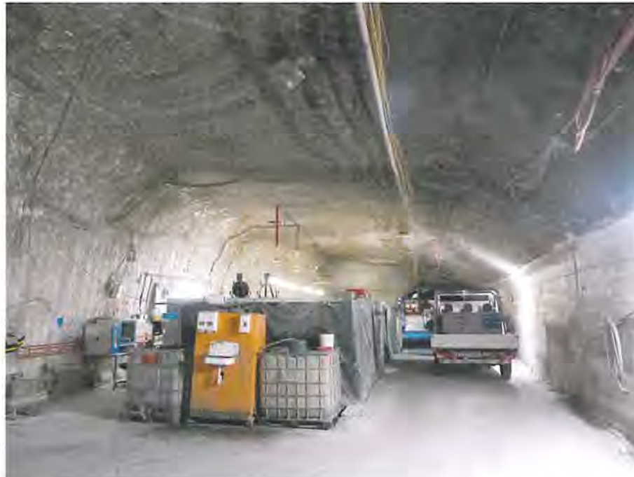
Abbildung 4.61: Pausenplatz in nordöstlicher Streckenaufweitung und mit Stützbauwerken stabilisierter Südstoß, Blick nach Südost (10.03.2020)
