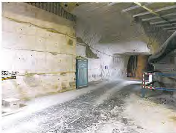
(a) Blick nach Westen in die Abbaubegleitstrecke vor Abbau 3/553 auf der 553-m-Sohle, Stand: 23.04.2020
