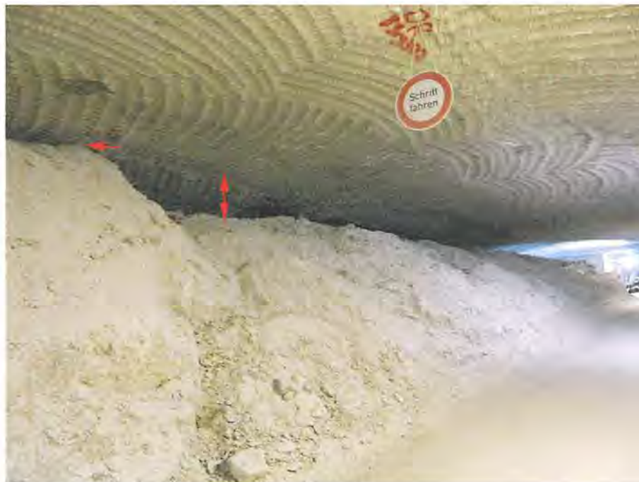
Abbildung 4.62: Entlang des Südstoßes von Abbau 5b/750 (Na 2 )gelagertes Salzhaufwerk mit Übergang von firstbündiger Lagerung im Osten zum westlichen Abschnitt mit Firstspalt, Blick nach Nordwesten (10.03.2020)
