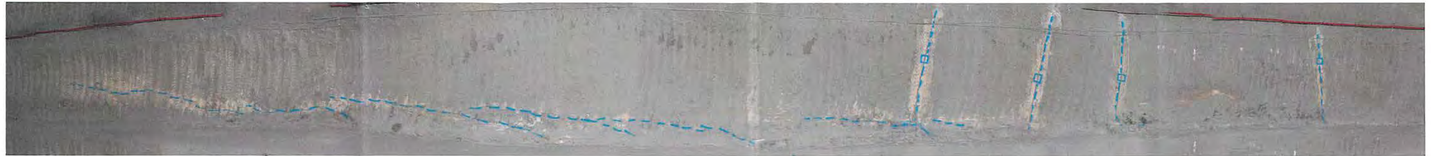
Panoramaaufnahme Nordstoß im Bereich des Pfeilers 4/5
