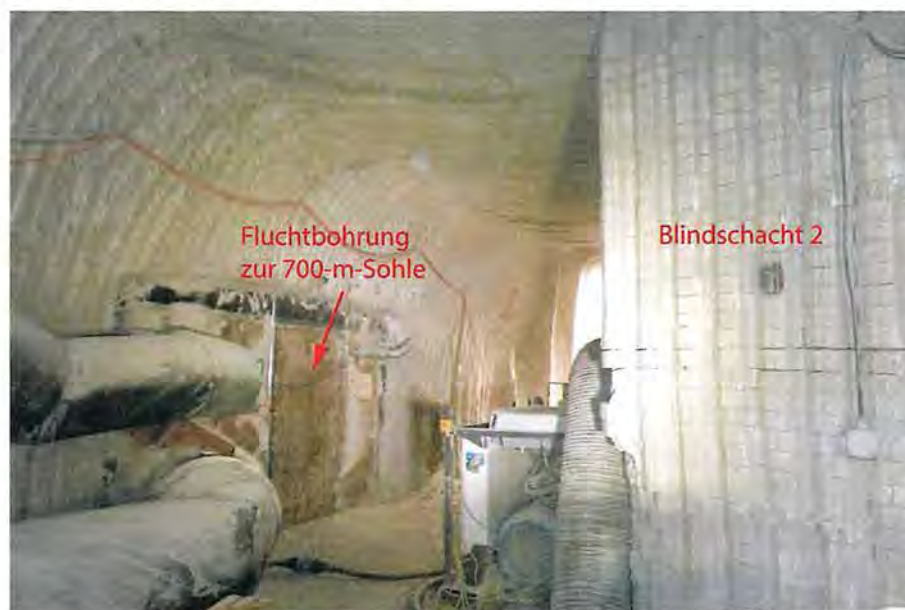
Abbildung 4.46: Nachgeschnittener Pfeiler 4/5, östlich des Lösungssumpfs (P725007) mit abgemauertem verfüllten Blindschacht 2 sowie nördlich davon in einer Nische verlaufende Fluchtbohrung zur 700-m-Sohle, Blick nach Osten, 02.03.2019
