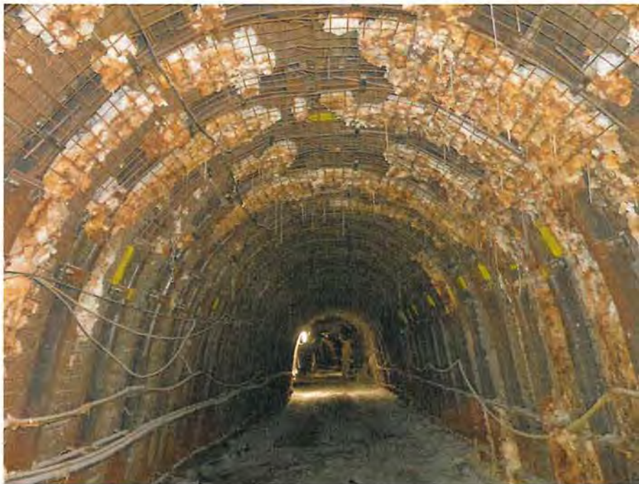
Abbildung 4.41: Gleitbogenausbau in Abbau 3 mit korallen- und stalaktitenförmigen Salzausfällungen im zentralen Bereich, Blick nach Osten, 02.03.2020
