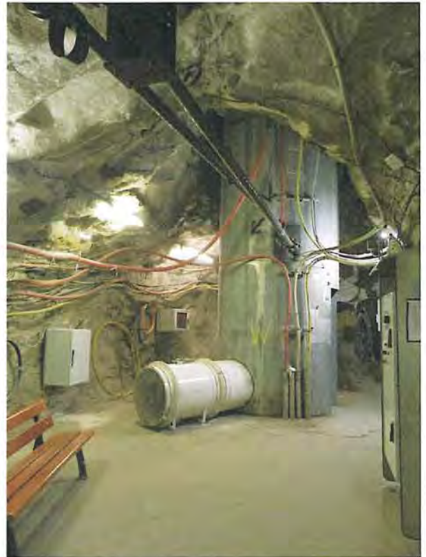
(b) Blick auf den Schacht 4 am Füllort auf der 490-m-Sohle, Stand: 27.02.2020
